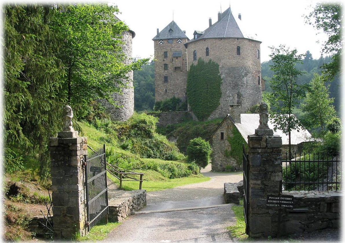
Kasteel Reinhardstein. Het kasteel, vandaag uniek in België, werd opgetrokken in 1354. Nadat het was vernield, werd het vanaf 1969 herbouwd in overeenstemming met
