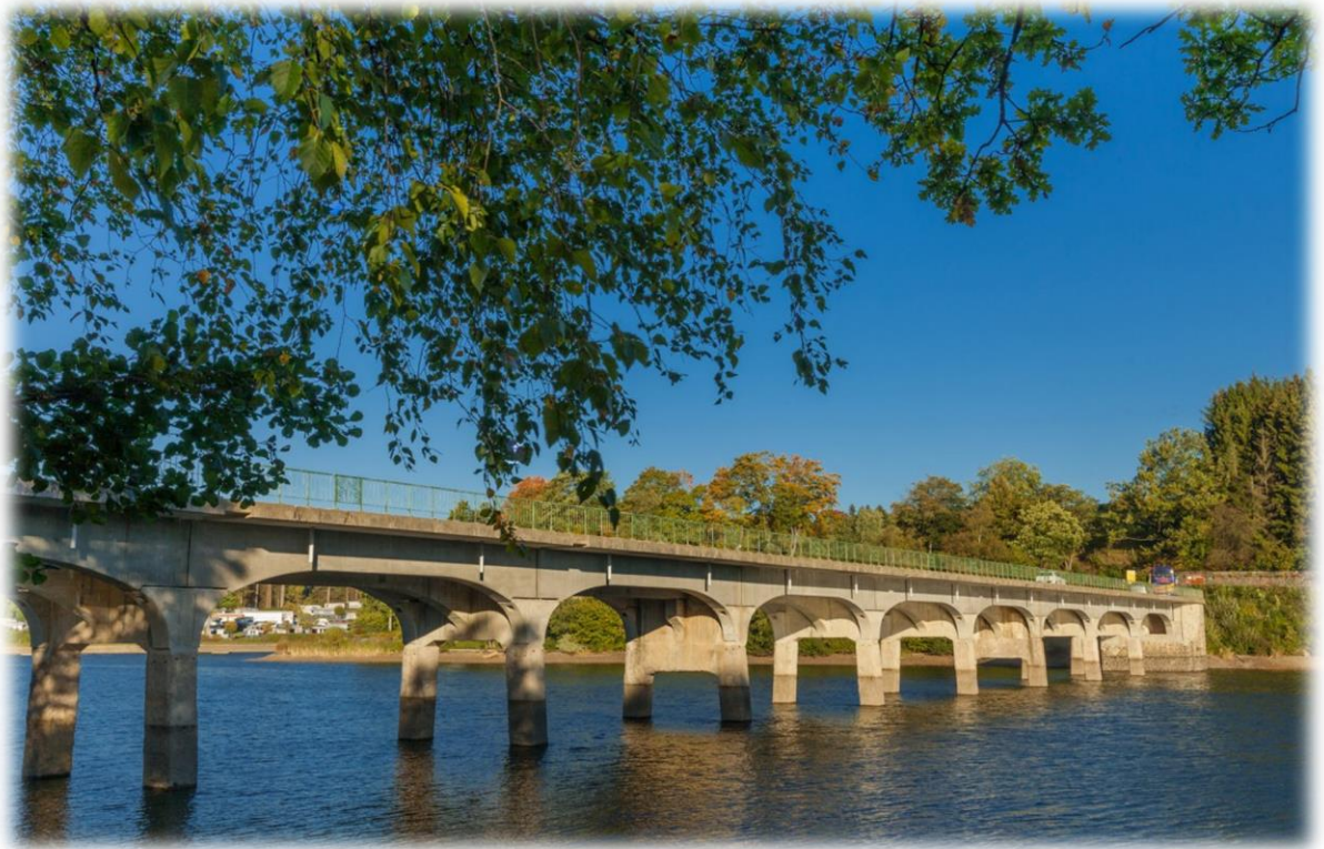
De brug van Haelen werd samen gebouwd met de stuwdam. De brug werd genoemd naar het dorp Haelen bij Diest waar het Belgische leger op 12/08/1914 een Duitse aanval had afgeslagen. In de zomer van 1944 hebben de Duitsers een deel van de brug opgeblazen om de
